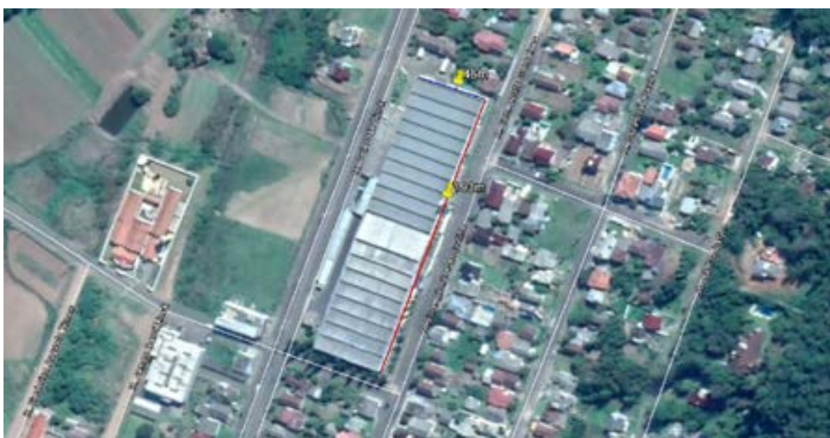
Figura 1: Telhado da Empresa, em 03/2017 (29°39'25" S, 50°34'28" O). Fonte: GoogleEarth.
