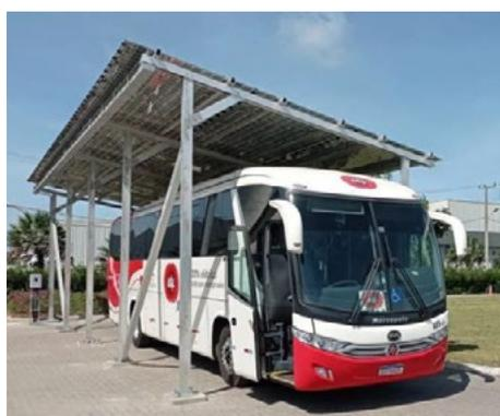
Figura 4. Estacionamento solar para abastecimento de ônibus elétrico
