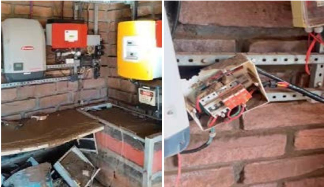
*Fonte: Do Autor, Sistemas On-Grid, Off-Grid e de armazenamentos de energia solar atingidos pela enchente na Fazenda Quinta dos Ventos.*
